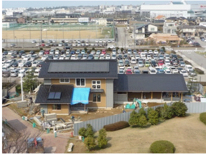
太陽熱温水パネル設置工事(平成22年3月17日)
