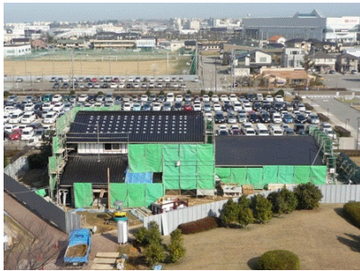
太陽光パネル(屋根一体型)設置工事後(平成22年2月25日)
