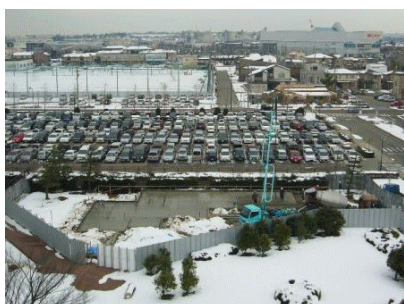
基礎工事(平成 22 年 1 月 18 日)
