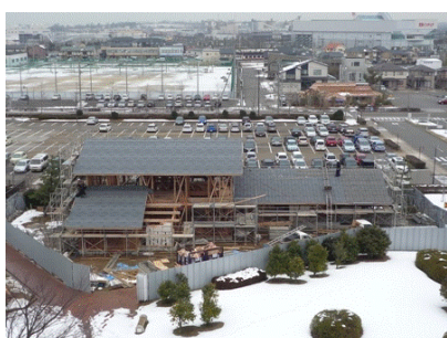
屋根工事(平成22年2月8日)
