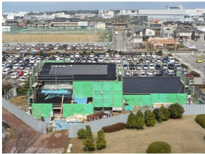
太陽光パネル(屋根上施工型)設置工事(平成22年3月3日)
