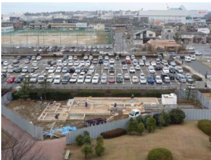
土台伏せ(平成 22 年 1 月 28 日)
