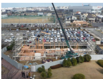
建て方(平成22年2月4日)
