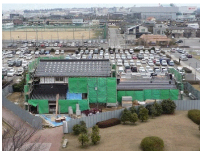
太陽光パネル(屋根一体型)設置工事(平成22年2月22日)
