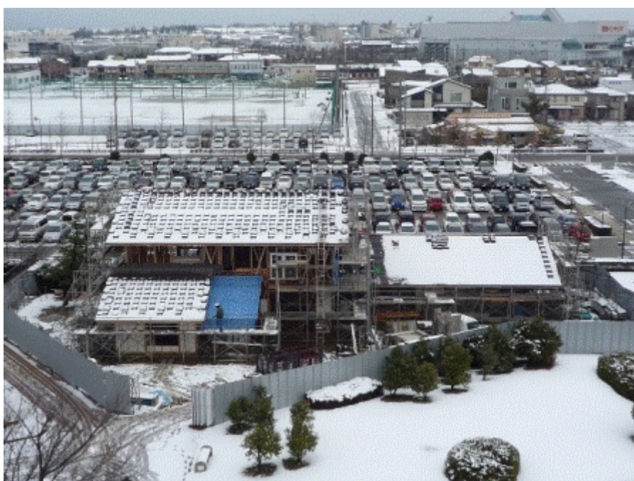
屋根工事・サッシ工事・断熱工事(平成22年2月16日)
