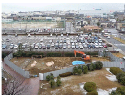
地盤改良工事(平成 22 年 1 月 10 日)
